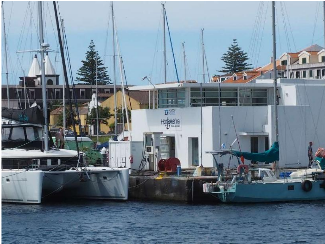
Brandstof steiger en havenkantoor Horta Marina
